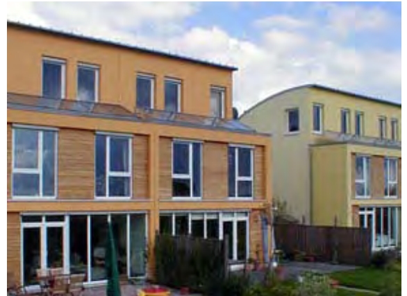
Solarsiedlung Erftstadt (Quelle: AVL Konzert Technik Köln)
