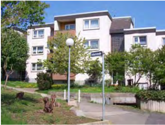
Mehrfamilienhäuser mit altersfreund- lichen Wohnungen in Odendorf
